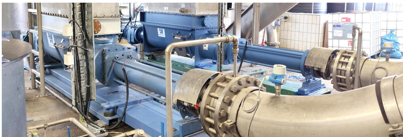
Einbau der Pumpen in der Anlage
