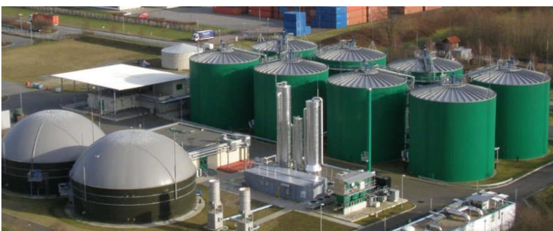
Erfolgreich getestet in der Biogasanlage TerraSol in Dorsten
