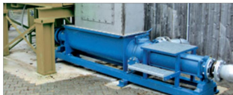
Plnění čerpadla za drtičem
